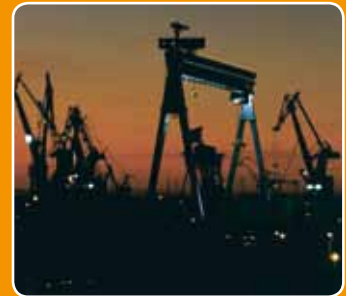
Grúa goliath para astillero.
