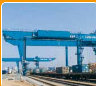
Grúa para containers.
